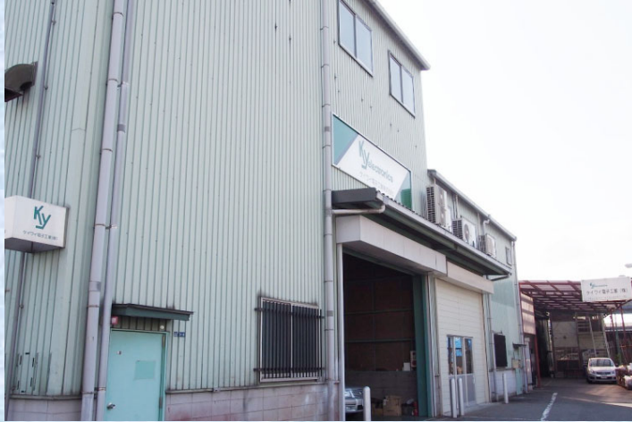
第二工場外観
